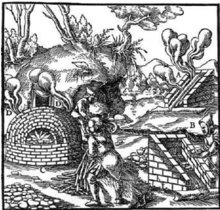
1556 - způsoby pražení olověných rud, dole vrstva rudy, na ní dřevo (Agricola 2001, 281).
