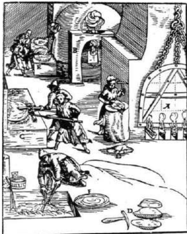
1574 - vycezovací, rafinační a třebící pece, měděné bochníky (Ercker 1974, 199).
