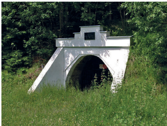
Zrekonštruovaný portál štôlne v Križskej doline. Štôlna mala nezvyčajný názov „flotačná“. Flotácia je spôsob oddeľovania rudy od hlušiny. Flotačná linka bola neďaleko tejto štôlne.
